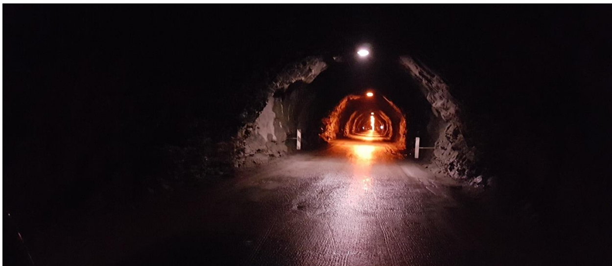
Pollfjelltunnelen på FV868 (Foto: Transportutvikling AS, 2018)
