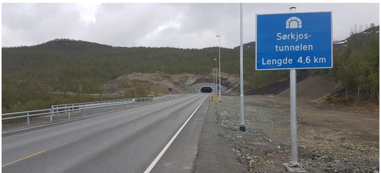
Sørkjostunnelen (Foto: Transportutvikling AS)
